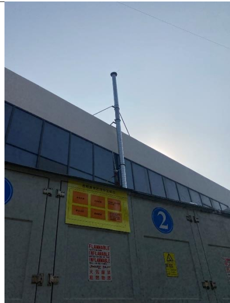
危废仓库废气排放口
